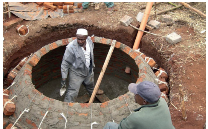
Bau einer Kleinbiogasanlage für kenianische Bauern (mit Genehmigung von atmosfair, Quelle: www.atmosfair.de )
